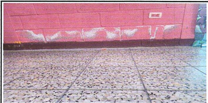
Foto 2: Mejoramiento de socalo
