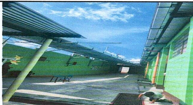
Foto 3: Mejoramiento de sistema electrico
