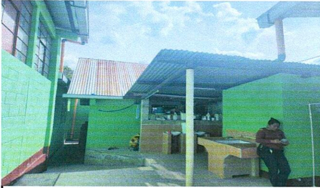
Foto 1: Mejoramiento de techo, bodega, baños y patio
